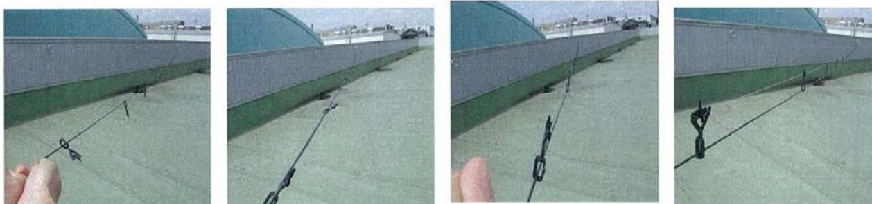
6 電柱側のテグスの端末にも「手順1. 2. 3」同様にSCHを取り付けて張力を掛けたまま「手順7」の作業を行い完成です。
